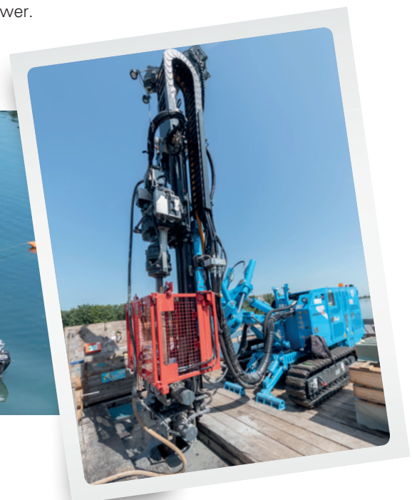
Mit Ponton und Bohrgerät erfolgte die Entnahme von 20 Meter langen Bohrkernen aus dem Flussbett.
