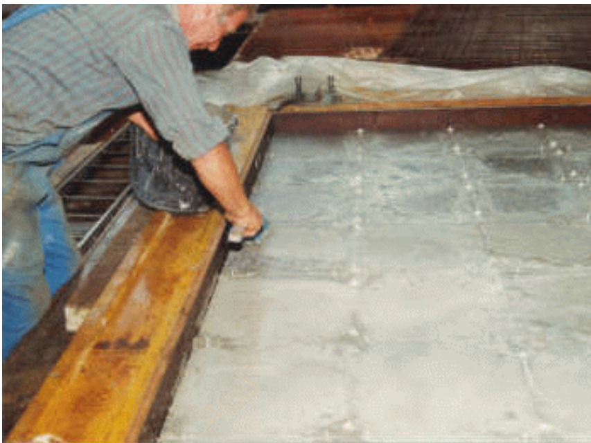
Abbildung 2 Aufbringen der Haftbrücke
