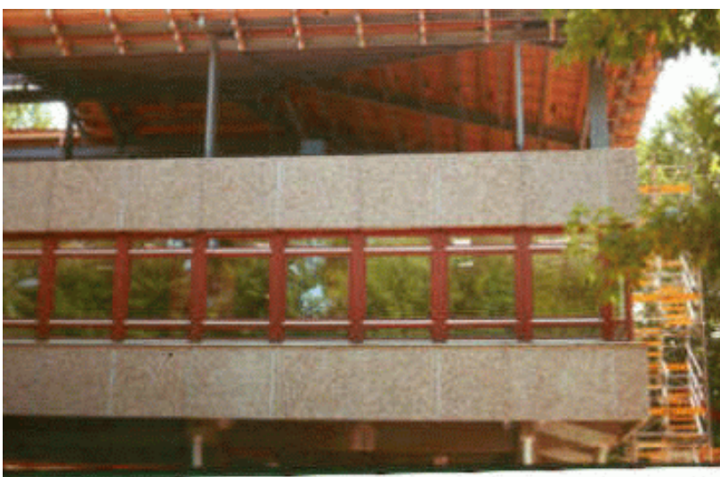
Abb. 4: Aufstockung eines Verwaltungsgebäudes erfordert die Erhöhung der Tragfähigkeit der letzten Geschoßdecke
