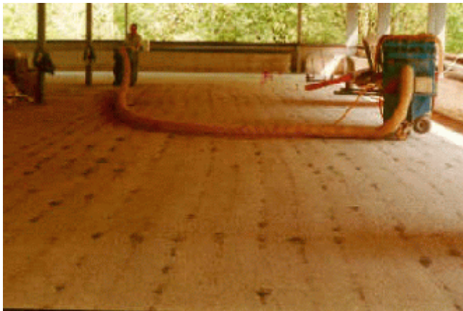
Abb. 6: Vorbereitung der zu verstärkenden Geschoßdecke durch Kugelstrahlen
