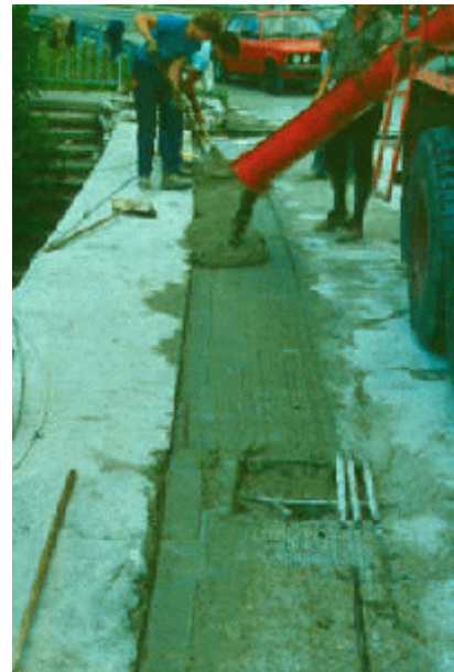
Abb. 9: Einbau des Instandsetzungsbetons an einem Brückentragwerk
