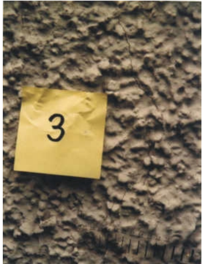
Bild 6: Netzriß in Rieselputz auf gerissenem Wärmedämmputz
