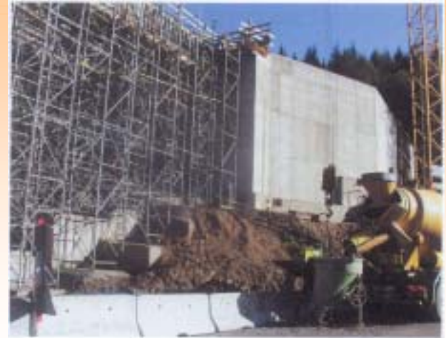
Brückenwiderlager: Betonsorte nach ÖNORM B 4710-1; C25/30/B5
