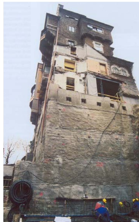
Bild 2: Unterfangungsarbeiten bei einem in Fels gründenden Schloss-Turm
