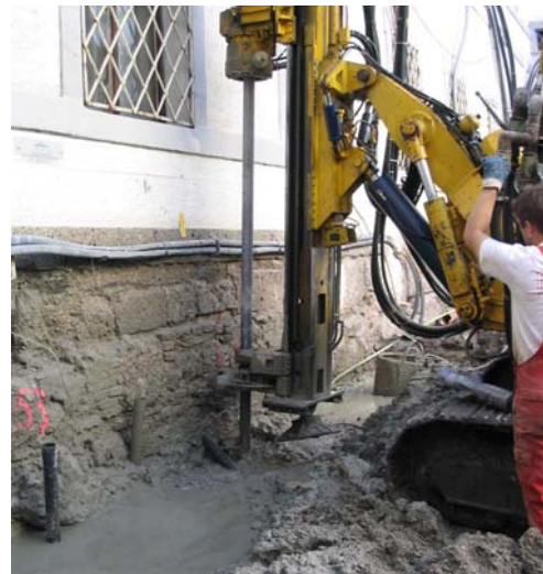
Bild 5: Unterfangungsarbeiten mit dem Düsenstrahlverfahren (DSV) an einem historischen Gebäude
