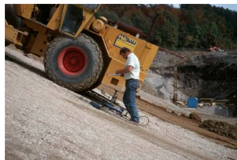
Bild 3: Statischer Plattendruckversuch (Einsatz in einer Deponieböschung)
