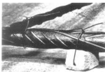
Abstandhalter unter der Bewehrung
