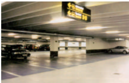
Tiefgarage im Grundwasser
