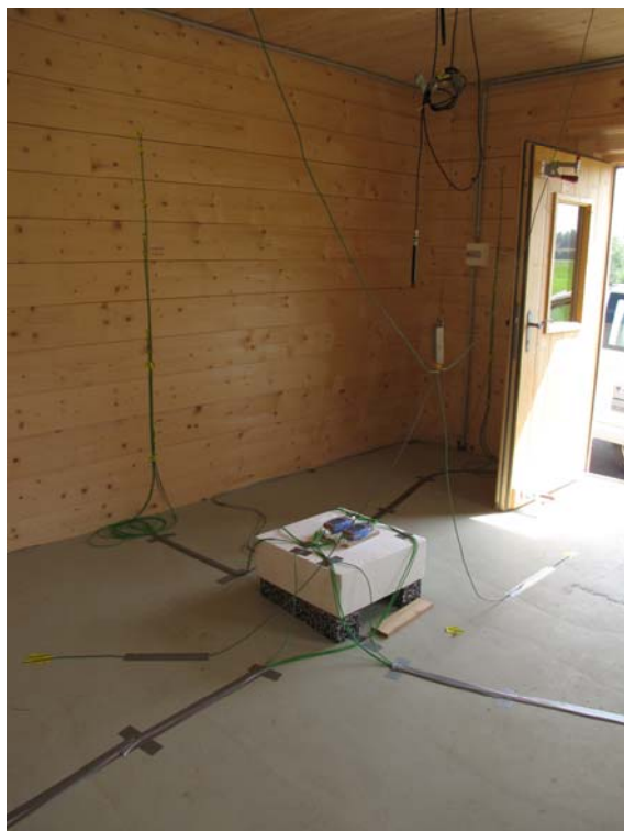
Bild 2: Anordnung der Messsysteme: Innenklima (Aufnahme bvfs)
