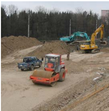
Bild 1: Einsatz einer Walze mit glatter Bandage im Verkehrswegebau (links) bzw. zur Verdichtung vor Einbau einer Bodenplatte im Hochbau (rechts)
