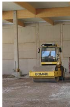
Bild 1: Einsatz einer Walze mit glatter Bandage im Verkehrswegebau (links) bzw. zur Verdichtung vor Einbau einer Bodenplatte im Hochbau (rechts)
