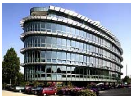
Bild 2: Beispiel eines Bürogebäudes mit hohem Energieverbrauch
