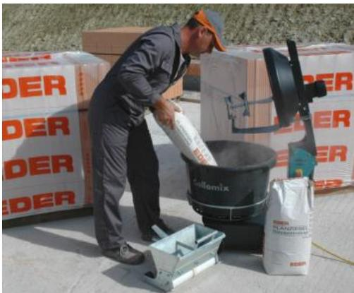
Abbildung 6: Rotationsmischer
