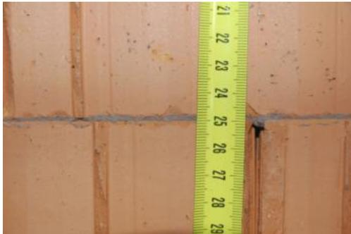
Abbildung 5: 1 mm dicke Dünnbettmörtelschicht
