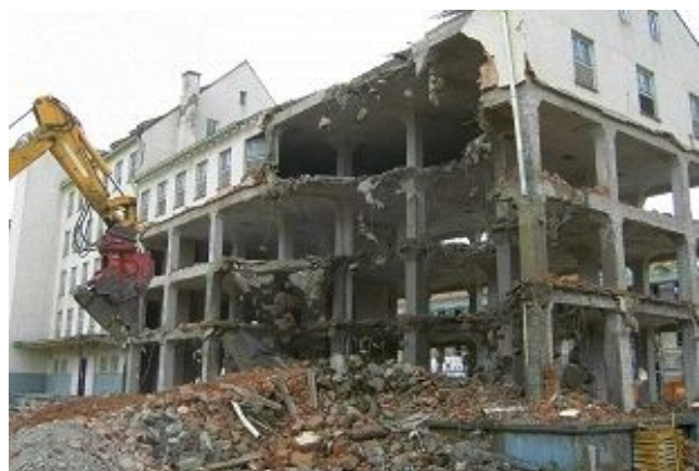
Bild 1: verwertungsorientierter Rückbau bei Hochbau-Abbrucharbeiten
