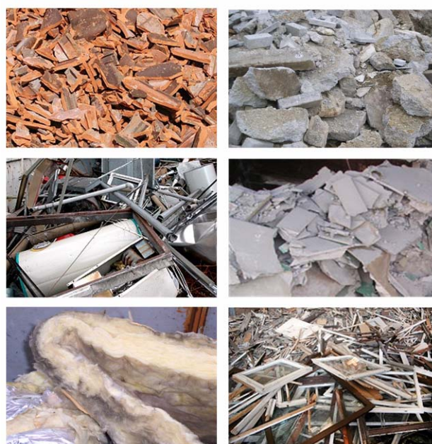
Bild 2: Sortenreinheit; Trennung der Abbruchmassen auf der Baustelle
