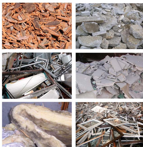
Bild 2: Sortenreinheit; Trennung der Abbruchmassen auf der Baustelle
