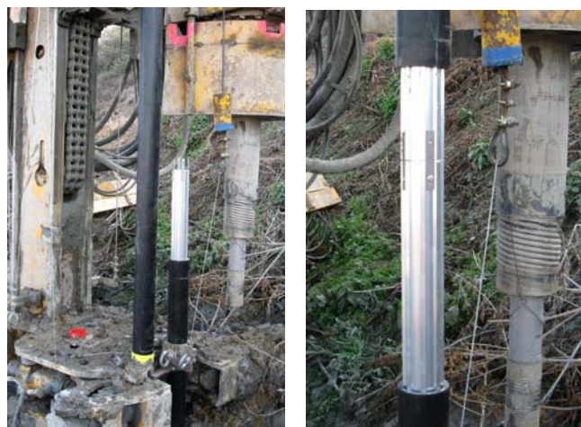
Bild 5: Einbau eines Neigungsmessrohres System bvfs in ein Bohrloch
