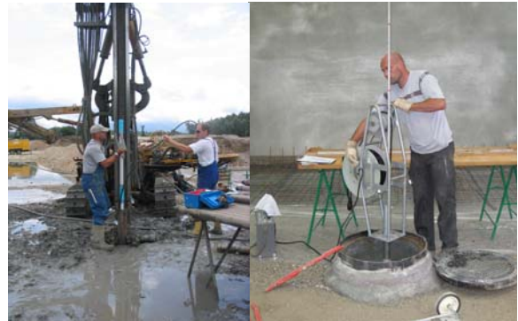
Bild 5: Einbau und Messung eines Gleitmikrometers in einem Bohrloch
