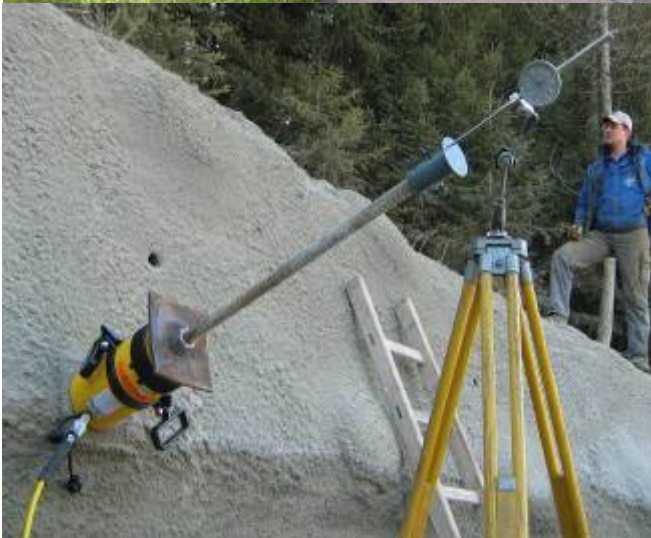
Bild 4: Zugversuche mit Erdnägeln (oben) und Bodennägeln (Injektionsbohranker, unten)
