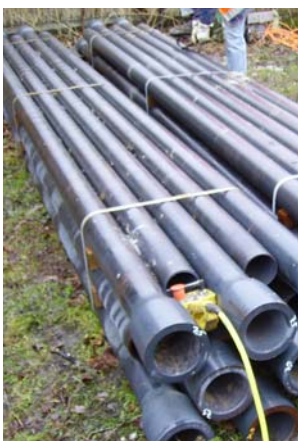
Bild 1: Kleinrammpfähle aus duktilem Gusseisen (links) und Kleinbohrpfähle System GEWI (rechts)
