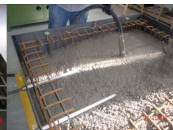
Bild 6: Einbringung des Betons in die Schalung
