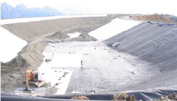
Bild 1: Dammschüttung für einen Speicherdeich
