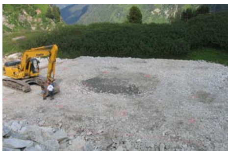
Bild 4: Befüllung der Versuchsgrube
