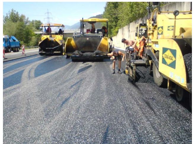
Bild 2: Befahrung der Vorspritzebene
