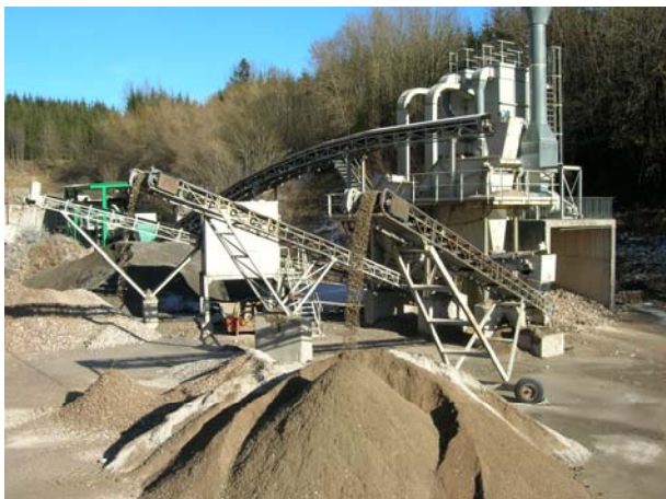
Bildquelle: SBR - Recyclingwerk Thalgau Stationäre Recycling Aufbereitungsanlage
