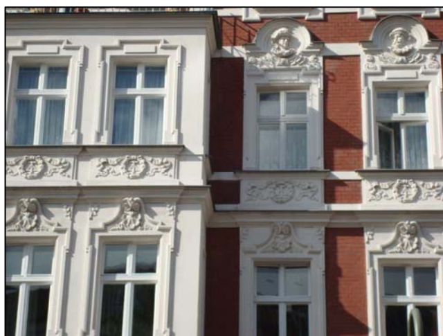
Bild 1: für Innendämmung typisches Fassadenbeispiel
