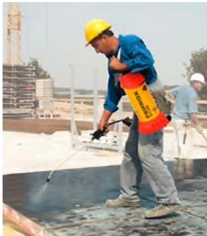
Bild 1: Aufbringen des Schalöls auf die Schalungsfläche
