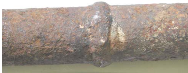
Bild 5: Detail Schweißung mit Schlagstelle (Aufnahme ÖGI/Leoben)
